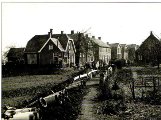
Aanleg van riolering aan de Holtentorensweg in Rijssen, jaren '30. Bron: Archief gemeente Rijssen-Holten.
